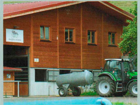
Das neue Stallgebäude mit großem Büro, Seminarraum und dem Reitsportgeschäft.
